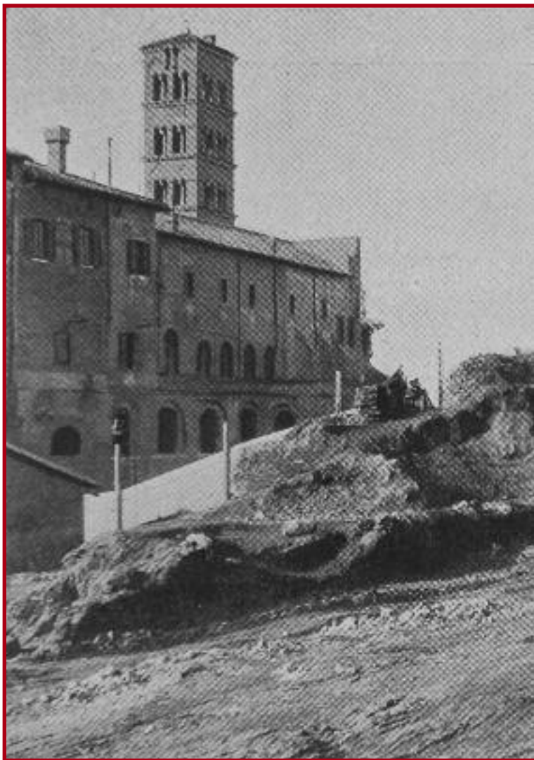
Lavori di scavo per l'apertura di via dei Fori Imperiali in corrispondenza del Compitum Acili
