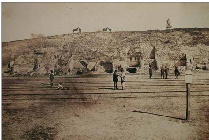
Scavi al Monte della Giustizia. Sono visibili le strutture di alcune case e la statua di Roma sulla sommità
